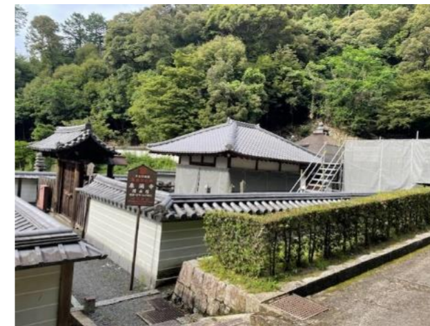
開山塔石塔解体を行いました。（令和6年6月7日、12日）
